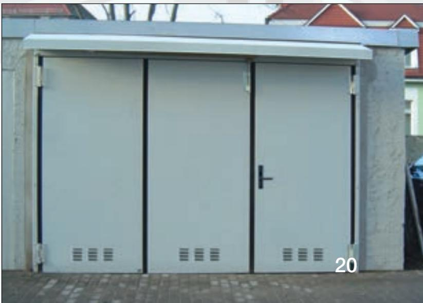
Trafogitter oder Lüftungsgitter speziell für Traforäume.
