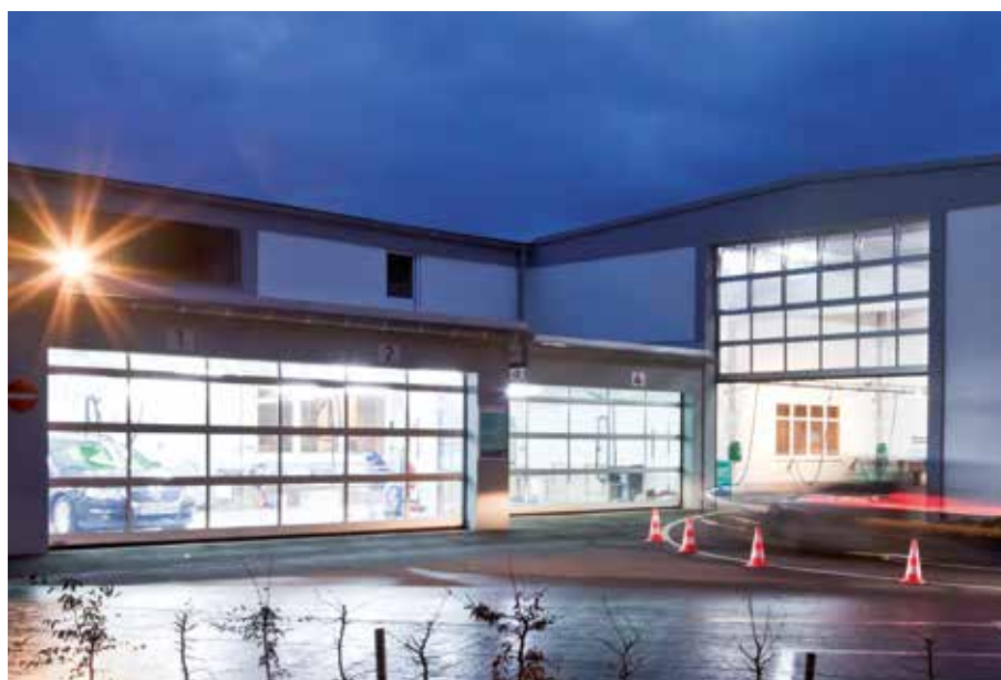
Saubere Torlösung: Typ SL 40 in einer Waschstraße
