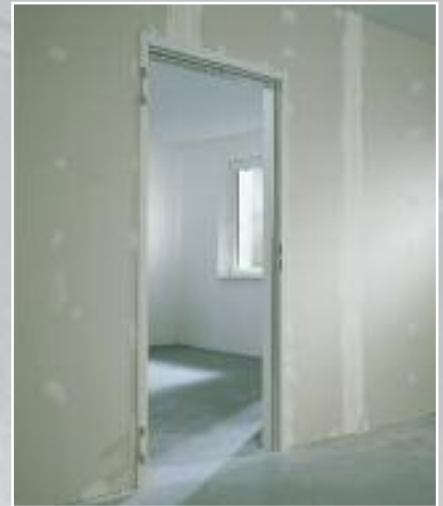
Fertig montierte Zarge in der Montagewand.
