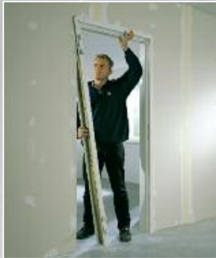
Einbau und Anpassung der mit Isoliermaterial vorgerichteten Schnellbauzarge.
