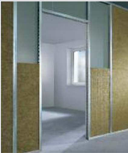
Einsatz der Dämmplatten in die Montagewand.
