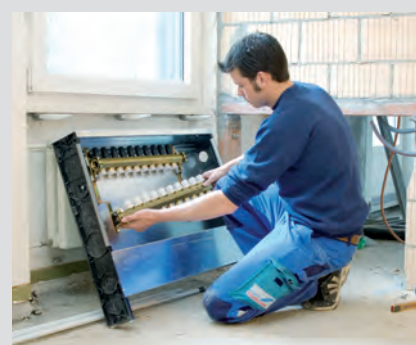
Einbau von Apparaten und Armaturen Heizungsinstallateurinnen und -installateure können Thermostaten, Fühler und Regelventile nach Montageanleitung des Lieferanten einbauen.
