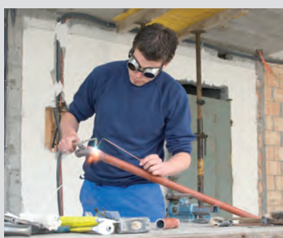
Handarbeit an der Werkbank Das Biegen, Schneiden und Schweißen von Rohren verlangt von den Heizungsinstallateurinnen und -installateuren handwerkliches Geschick.
