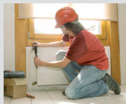
Heizkörper verlangen besondere Sorgfalt Kurz vor Bauvollendung erfolgt die Endmontage der Heizkörper (Radiatoren). Sie verlangt einen sorgfältigen Umgang mit der Umgebung und dem Material.
