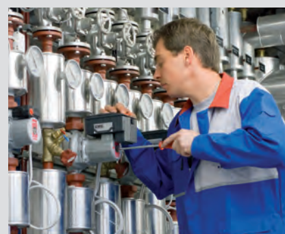
Unterhalts- und Servicearbeiten Nicht selten obliegt den Berufsleuten auch die Wartung von Heizungsanlagen. Das verlangt ein kundenge-rechtes, freundliches Auftreten.
