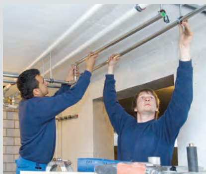
Montage der Kellerverteilung Im Keller wird das Trinkwasser über eine Verteilbatterie an den Elektrowassererwärmer und zu den verschiedenen Verbrauchern geführt. Montagepläne helfen dabei.
