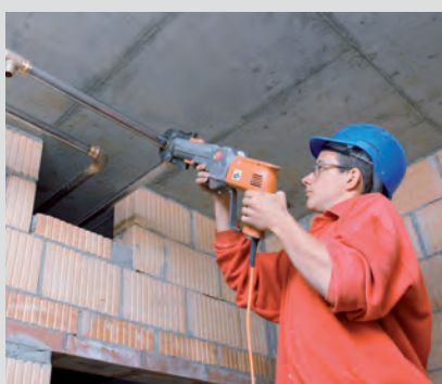
Der Einsatz von Handwerkzeugen Beim Verlegen der Rohre kommen Presswerkzeuge, Akkuschauber, Metermass, Rohrschellen und vieles mehr zum Einsatz.
