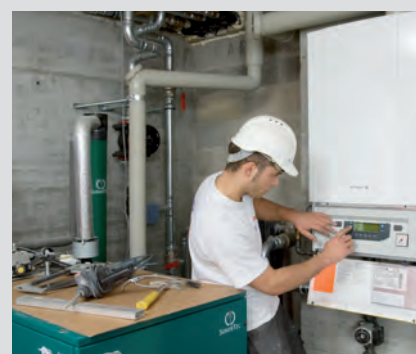
Installieren von Gas-Heizgeräten Die Berufsleute montieren moderne Gas-Heizgeräte für die Warmwasserbereitung. Sie verfügen über ein Grundwissen für deren sichere Montage.
